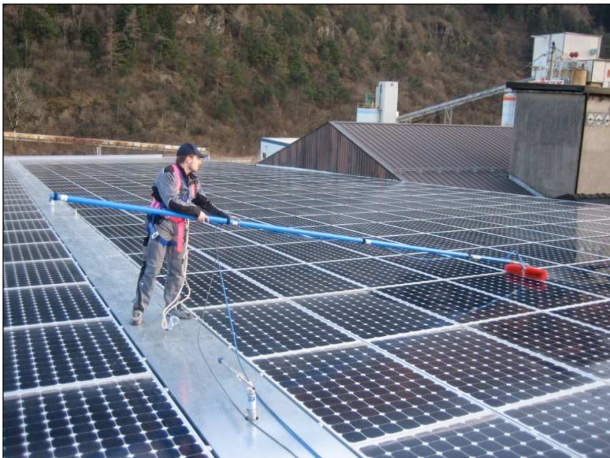
Abb. 1: Teleskopstange mit rotierender Bürste und Sprühdüsen (Foto: Lehmann KG)
