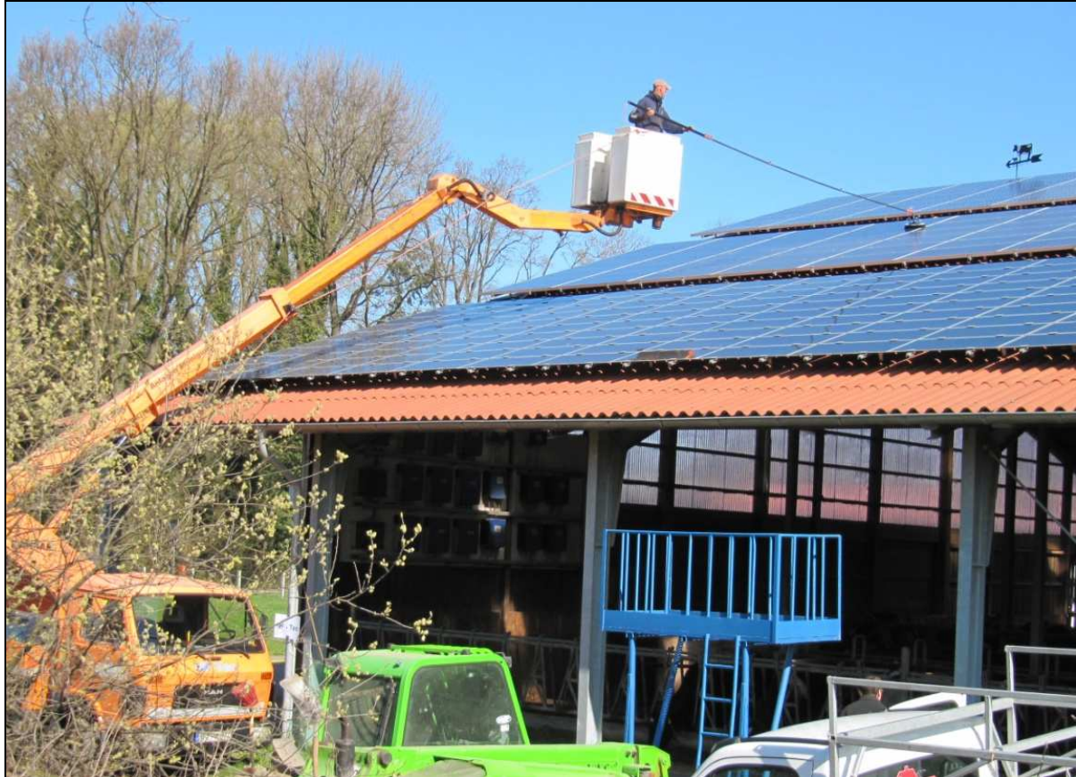
Abb. 7: Reinigung vom Hubsteiger aus (Foto: Eggersgluß)
