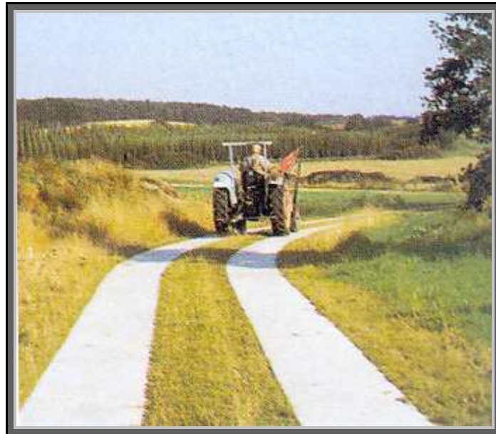
Abbildung 5: Der Landschaft angepasster Betonspurweg
