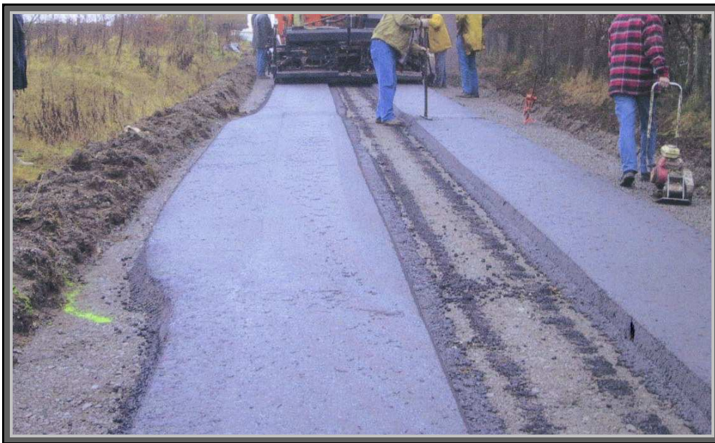
Abbildung 4: Verbreiterungen für Auffahrten, Spurbahnbau, Fa. bbb
