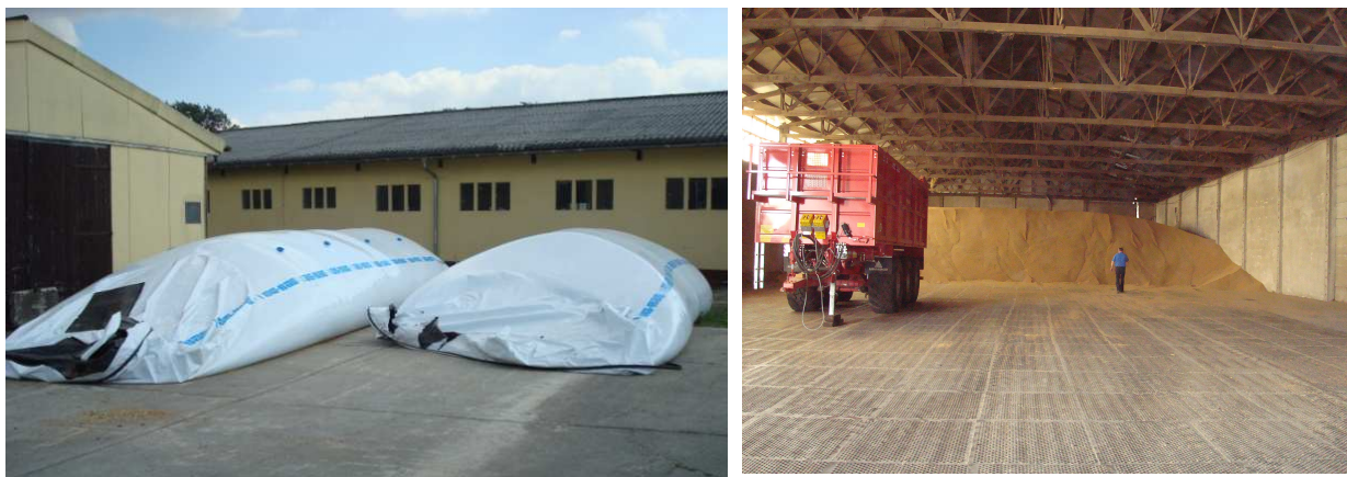
Abb. 9: Siloschläuche mit Weizen gefüllt und Lagerhalle als Vergleichsvariante
