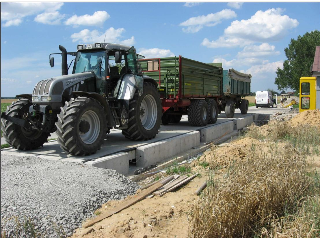
**Abb. 5:** Brückenwaage aus Betonfertigteilen im Einsatz
