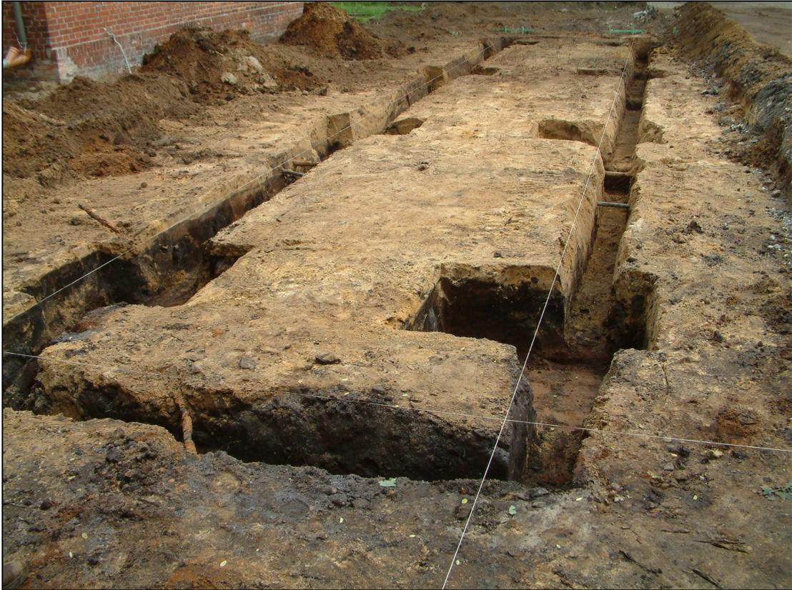
**Abb. 4:** Erdarbeiten zur Erstellung einer Brückenwaage
