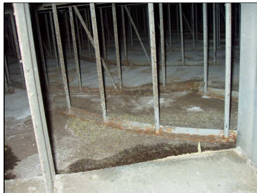
Abb. 13: Unterbau aus geschweißten, halbmondförmigen Blechhaltern
