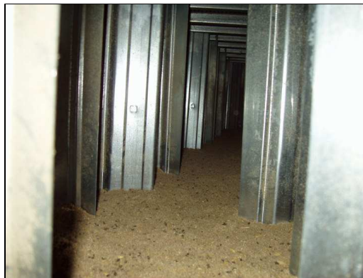
Abb. 12: Unterbau aus einzelnen abgekanteten Z-Blechen mit viel Abrieb unter dem 1 mm-Siebboden
