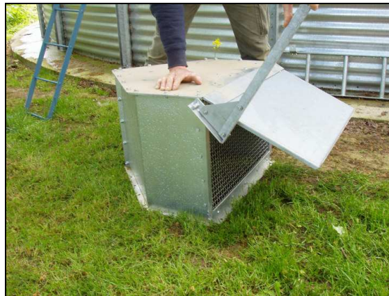
Abb. 3: Verschließbare Dach-Ablufthaube vor der Montage
