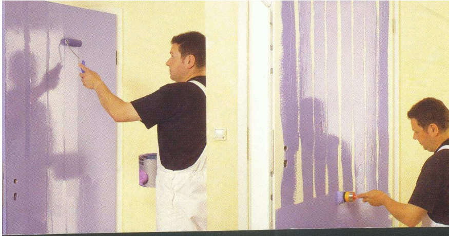
Abbildung 12: Eine Lackierung muss schnell aufgetragen werden, damit der Lack gut erlaufen kann bevor das Lösemittel entweicht
