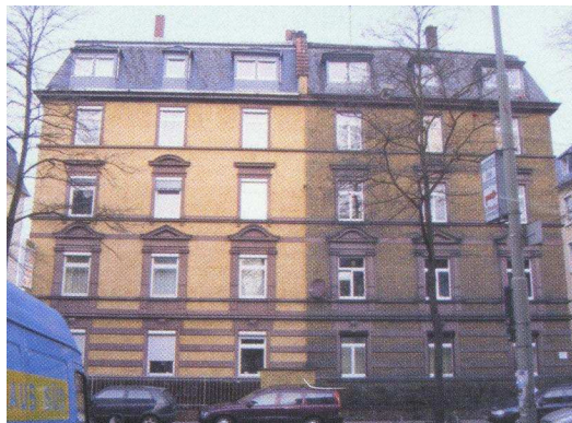
Abbildung 5: Fassade aus Verblendmauerwerk vor und nach der Reinigung und anschließender Hydrophobierung
