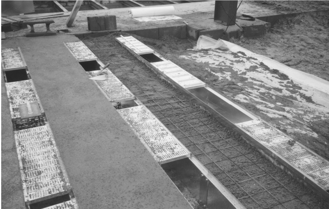
Abbildung 27: Unterflurkanäle während der Einbauphase
