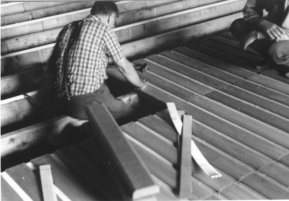
Abbildung 28: Hartholzbelüftungsboden mit Streckmetall während der Montage (Werkbild Dieckmann)
