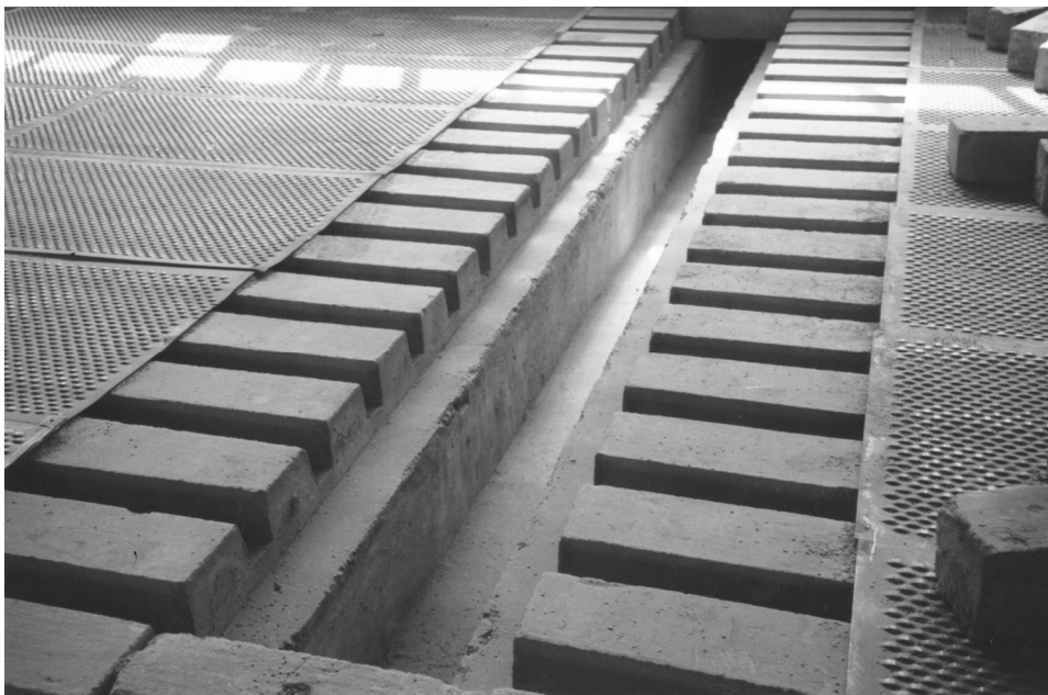
Abbildung 30: Befahrbarer Belüftungsboden mit Beton-Unterkonstruktion. Der Hauptluftkanal ist freigelegt.
