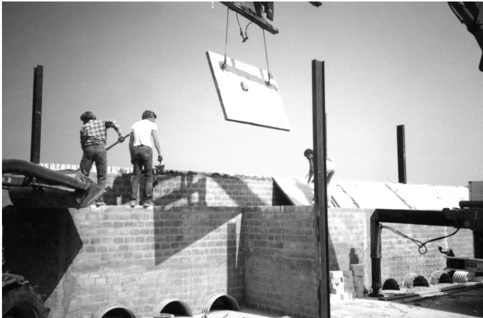
Abbildung 18: Kanalabdeckung mit selbstgegossenen Betonplatten, eingelegter Baustahlmatte und Montageösen zum Verlegen (Bauweise Ketelsen, Sönke-Nissen-Koog)
