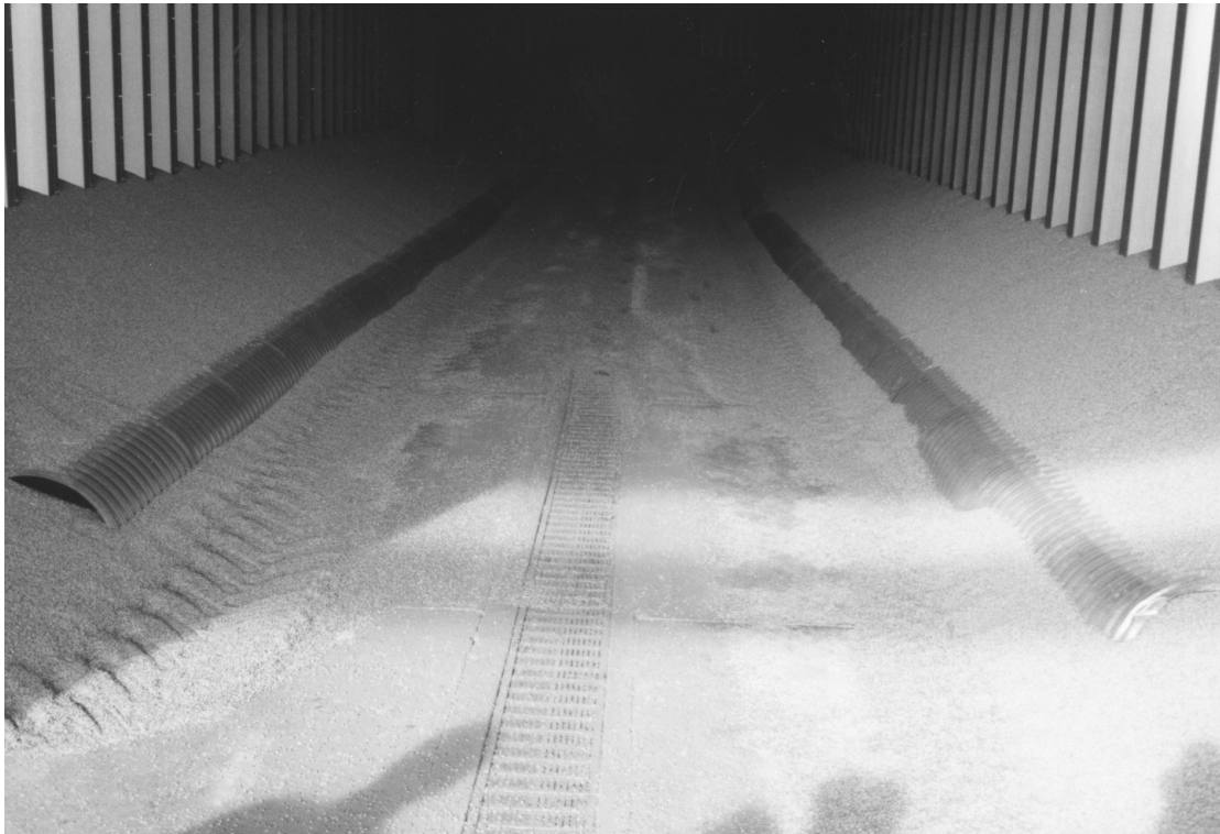
Abbildung 26: Eingebauter Unterflurkanal als Orientierungshilfe bei der Zellenentleerung
