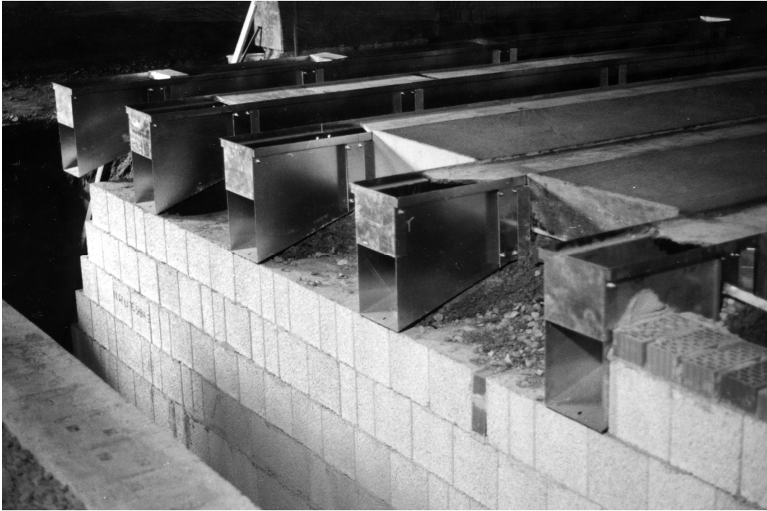
Abbildung 23: Unterflur-Hauptluftkanal während der Bauphase (Werkbild Dieckmann)
