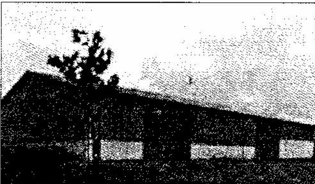
Abb. 45: Lagerhalle mit Trapezblechverkleidung
