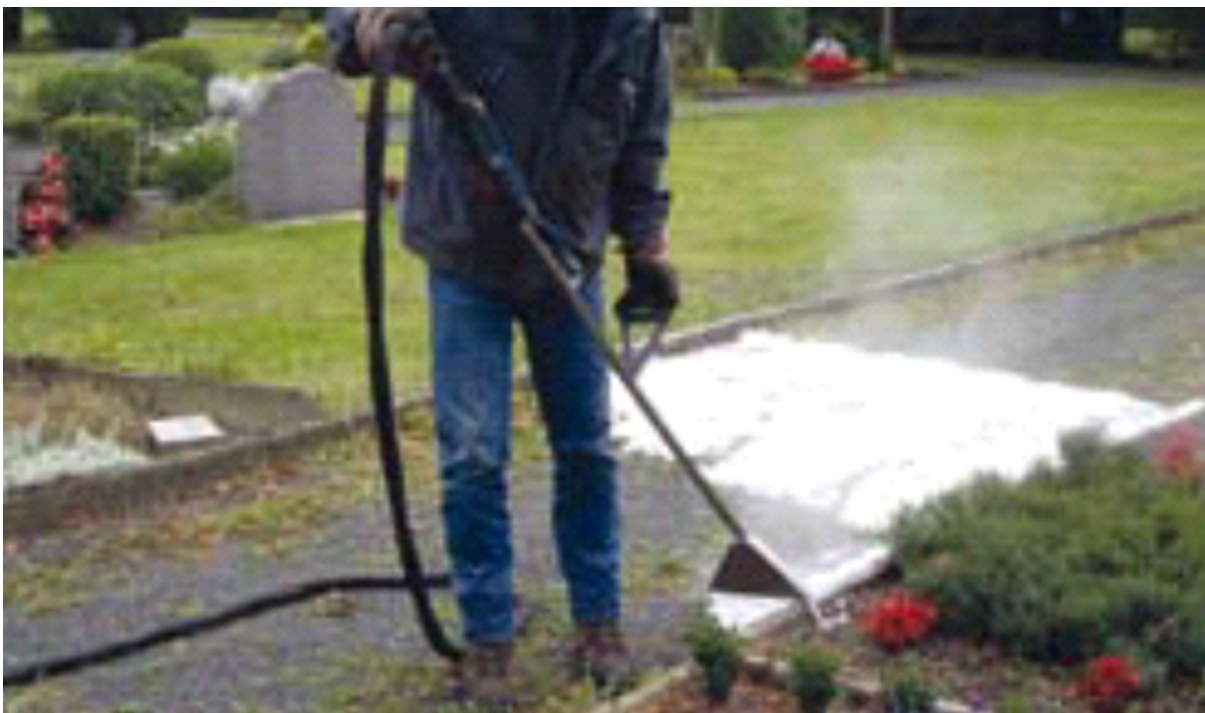
Abb. 4: Heißwasserverfahren zur Unkrautbekämpfung
