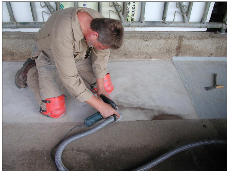
Abb. 4.6: Vor dem Aufbringen von Beschichtungssystemen sind gründliche Vorarbeiten, im Bild das Entfernen vom Zementschleier, nötig.
